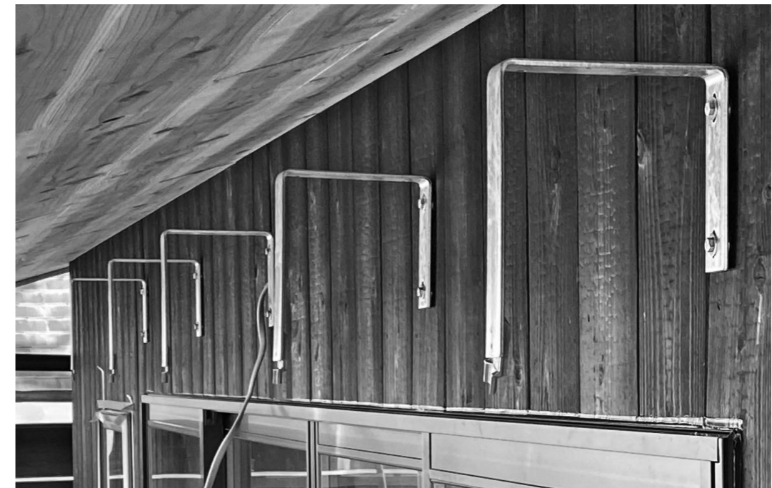
<マウンティングブラケット取り付けイメージ>
